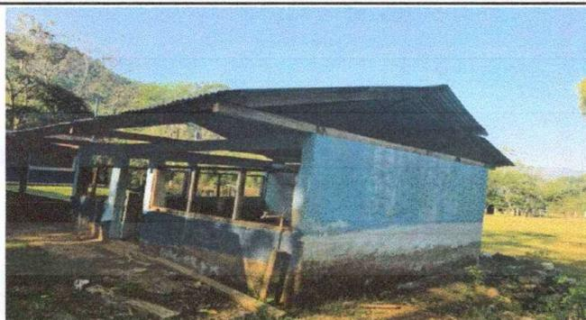
Foto 3: Cambio de estructuras metálicas, láminas oxidadas, ventanas y piso de tierra.
